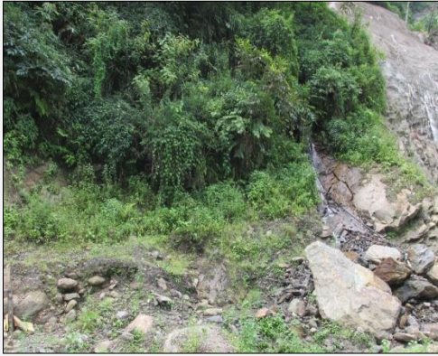
Desander construction site
